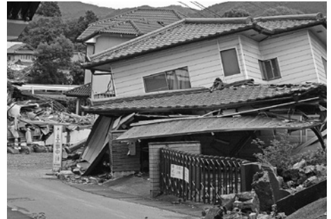
熊本地震被害状況
